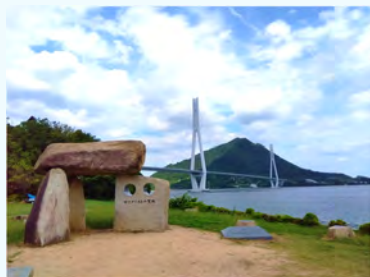
多々羅大橋
